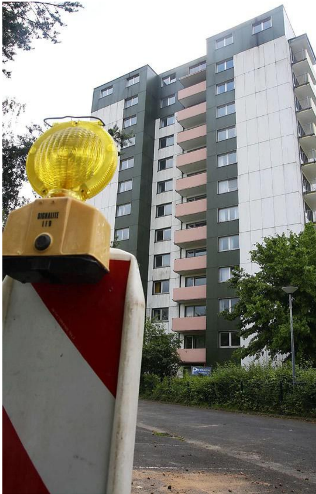
Für die Sanierung des Hochhauses „Am Richtsberg 88“ ist bereits eine Millionensumme von der Allianz-Versicherung in Richtung Studentenwerk Marburg überwiesen worden. Foto: Björn Wisiker
