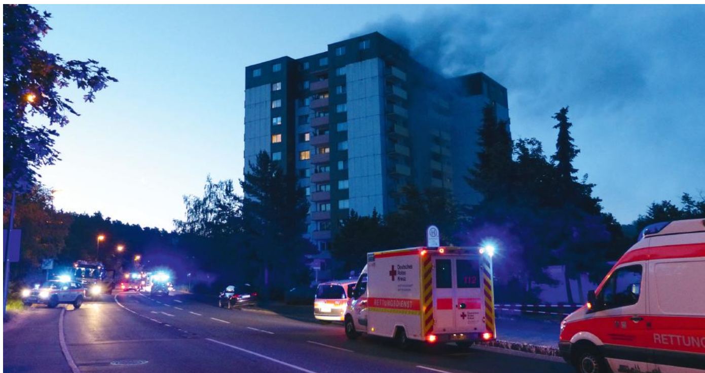
Brandrauch dringt aus dem Hochhaus „Am Richtsberg 88“
