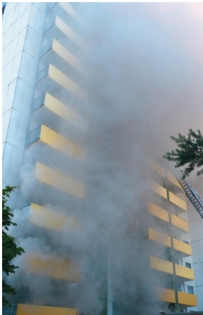
Brandrauchaustritt aus den Lüftungsschächten des Kellers beaufschlagt die Fassade.
