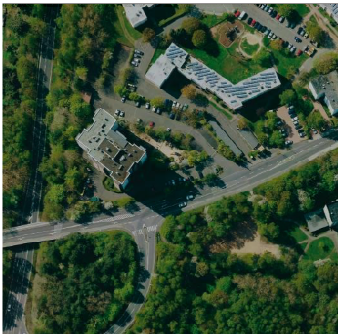
Luftaufnahme der Einsatzstelle.
