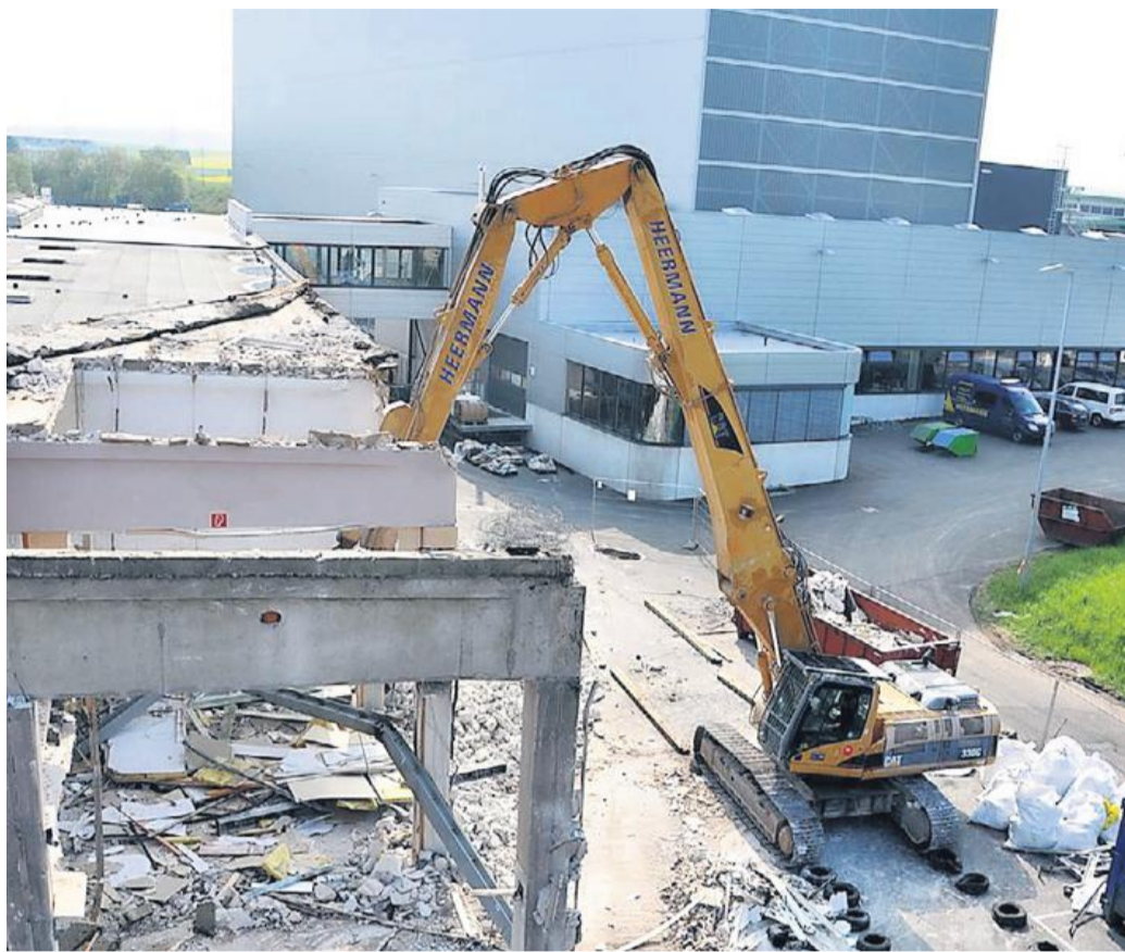
Seit einigen Wochen laufen auf dem Gelände der Marburger Tapetenfabrik die Abbrucharbeiten des zerstörten Druckereigebäudes. Foto: Constance Wingender (Marburger Tapetenfabrik)
