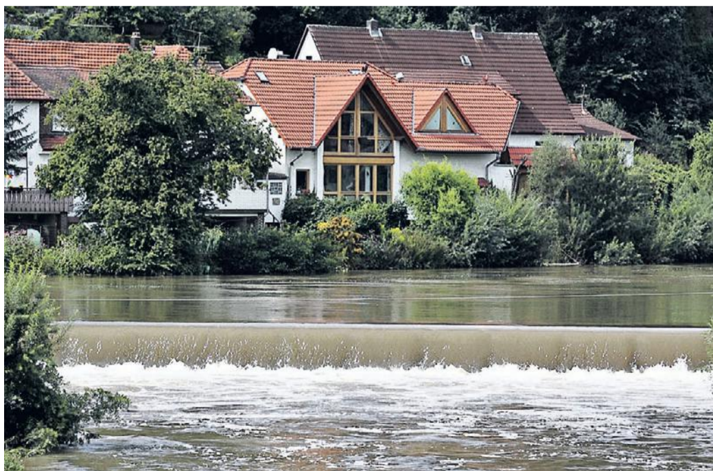
Das Lahn-Wehr in Marburg-Wehrda. Hier endete für einen 35-jährigen Betrüger die Flucht vor der Polizei. Foto: Thorsten Richter
